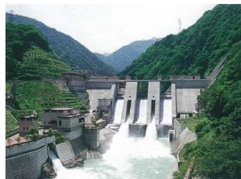
完成直後の宇奈月ダム
