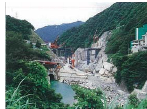
建設中の宇奈月ダム (H5.7)
