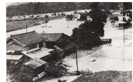
愛本付近の浸水状況
