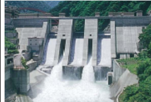
宇奈月ダム堤体
